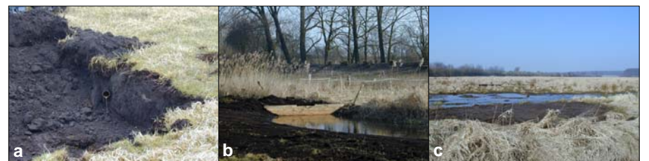
Abb. 6: Maßnahmen der Stufe I, a. Aufnahme von Drainagen, b. Aufstau von Gräben und Abflachung des Grabenufers, c. Abflachung der Ufer von Gräben und Mulden
